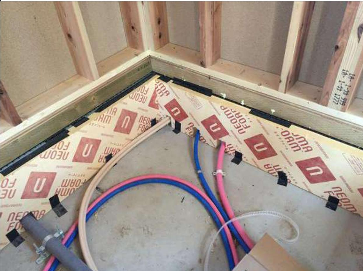
2-5口防湿層（気密シート）は幅広の長尺シートを用い、連続させ、隙間が出ないように施工する。継ぎ目は下地材のある所で30mm以上重ね合わせる。
