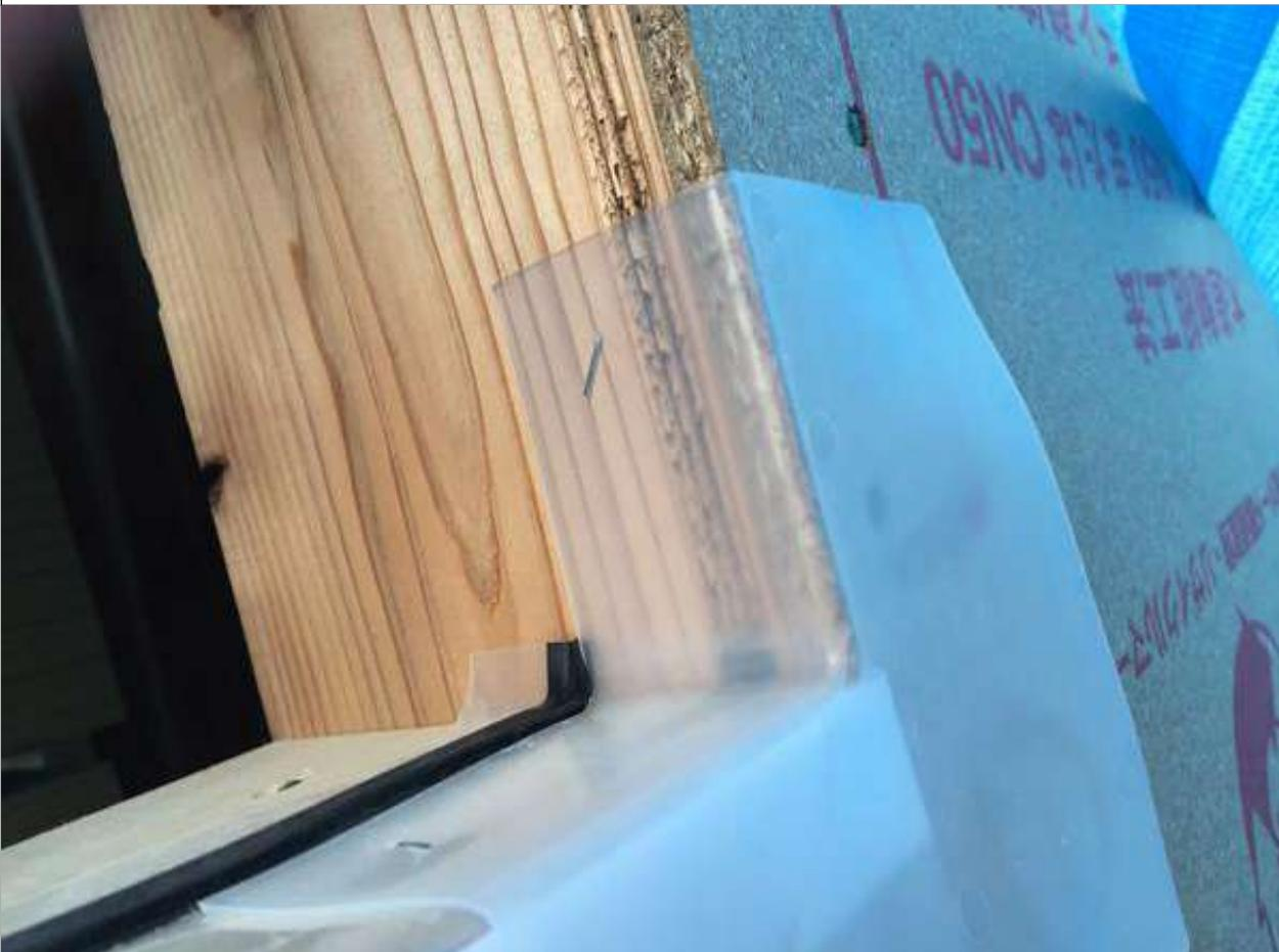
3-2口両面防水テープを用いて、サッシくぎ打ちフィンの根元を十分に覆い、縦・横の防水テープ交差部にすき間が生じないように張る。
