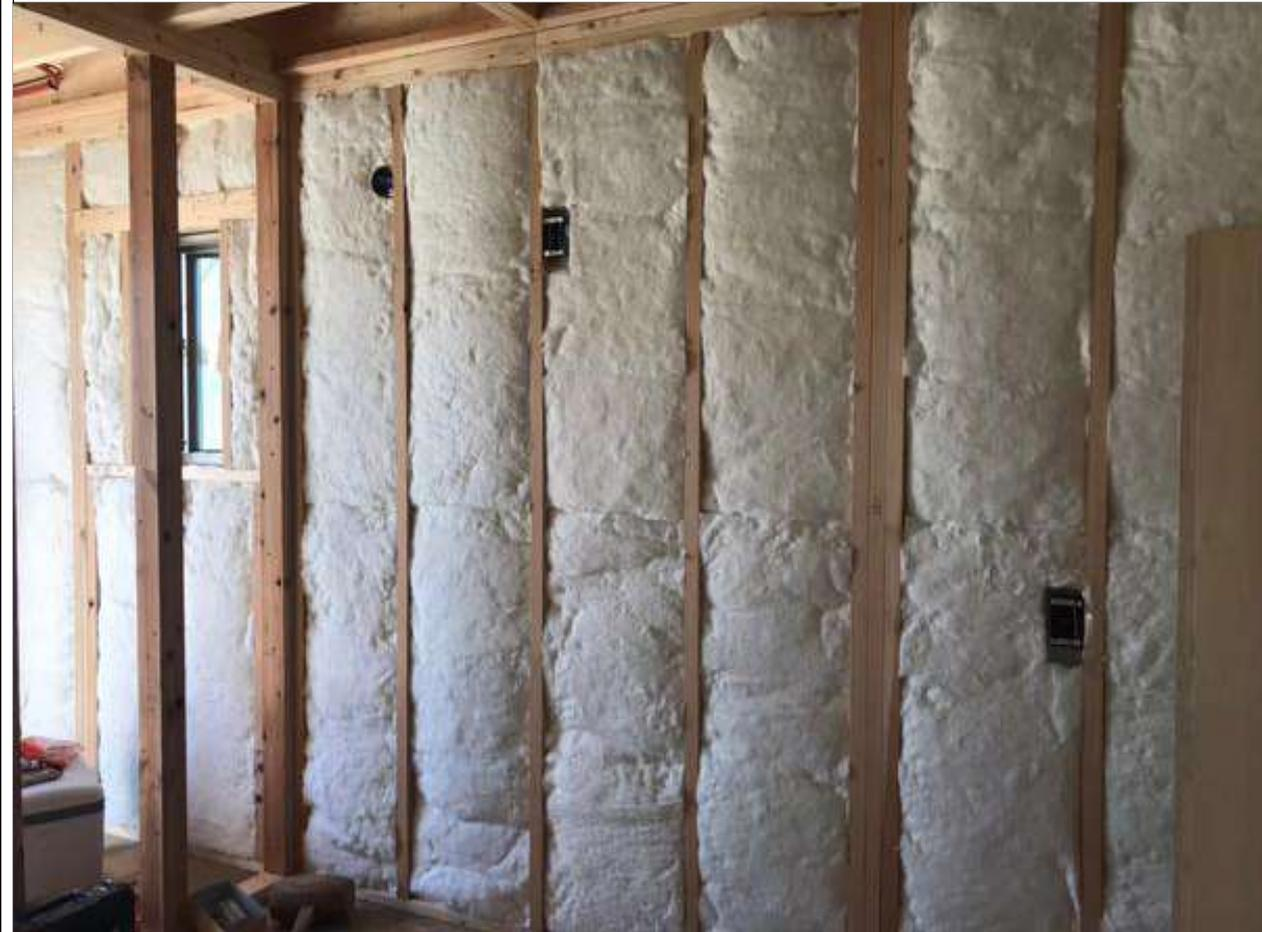
2-3口断熱材は隙間・欠損・施工不良がないように施工する。断熱材は配管部分に隙間ができないように気を付ける。
